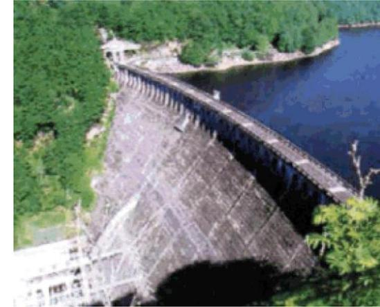
*Ouvrage massif avec risque de fissuration par dilatation thermique empêchée*
