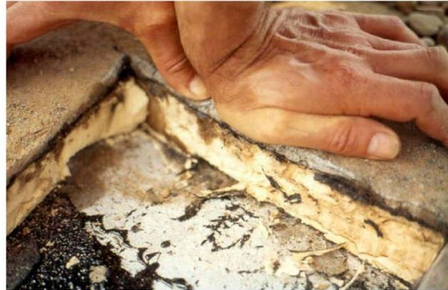
Moisissure sous isolant thermique
